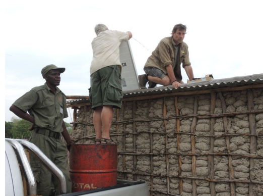
Errichtung einer Solaranlage
