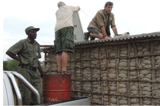
Errichtung einer Solaranlage
